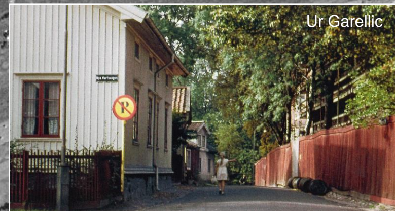
Småhus i gatuliv (6 m gatubredd) som revs vid bygget av Oscarsleden
